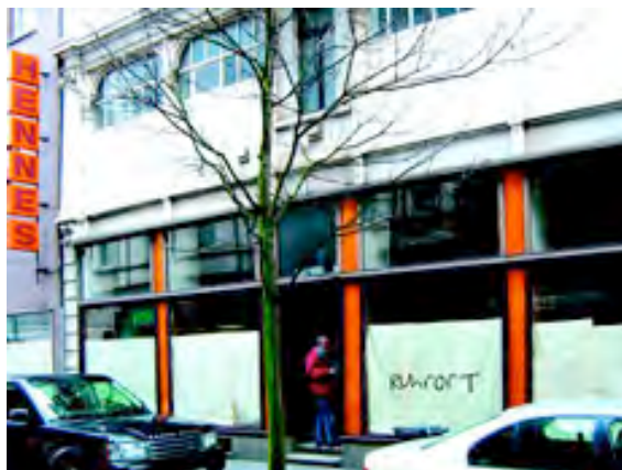
Ehemalige Eisenwarenhandlung Hennes © TAD 2007 Arbeits- und Aufführungsort von TAD in Duisburg-Ruhrort
